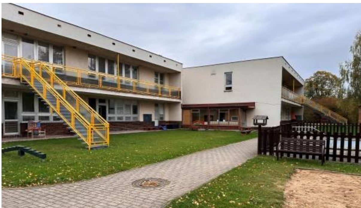
Žďárská – rozsáhlá oprava požárního schodiště
