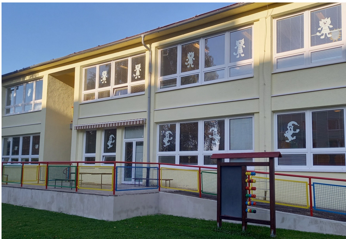
Drobného – svépomocí oprava teras a nátěry zábradlí a všech herních prvků
