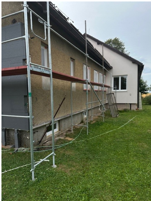
Pohledec – zateplení a nová fasáda druhé části budovy
