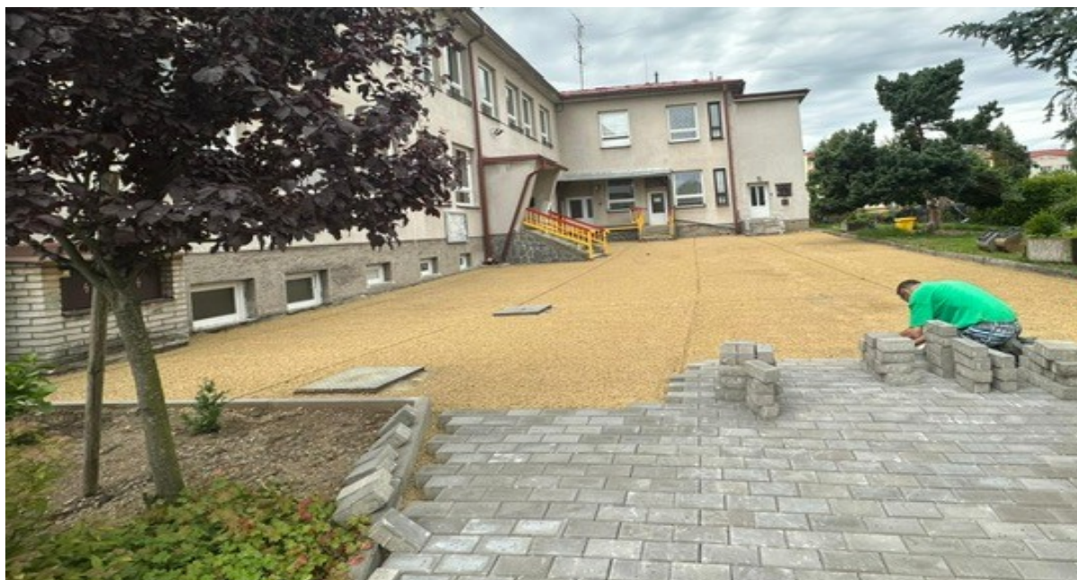
Slavkovice – oprava zpevněné plochy
