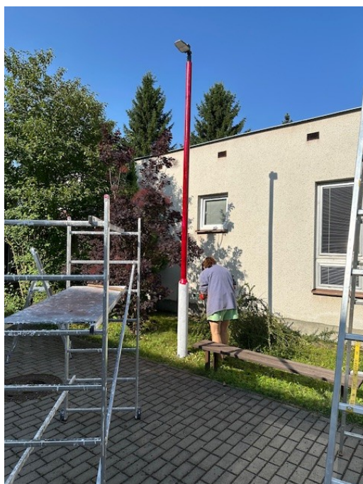
Žďárská – nátěr světél a nový telekomunikační systém
